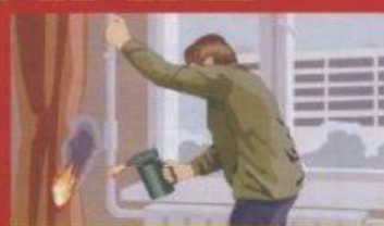
Отогревание замерзших труб паяльными лампами и факелами
